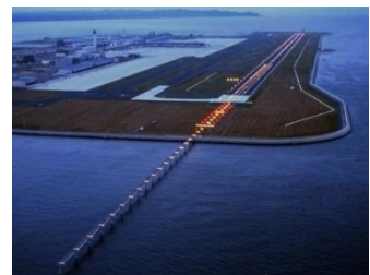
進入灯橋梁・航空灯火
