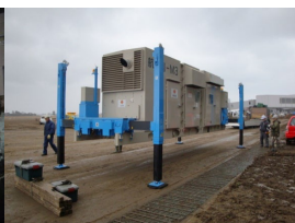
可搬形発電設備を設置
