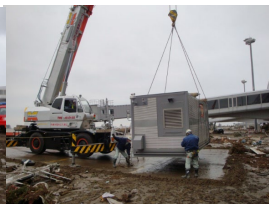
可搬形発電設備を設置
