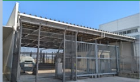
制限区域への出入りを管理する電動ゲート
