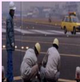
灯火の交換作業
