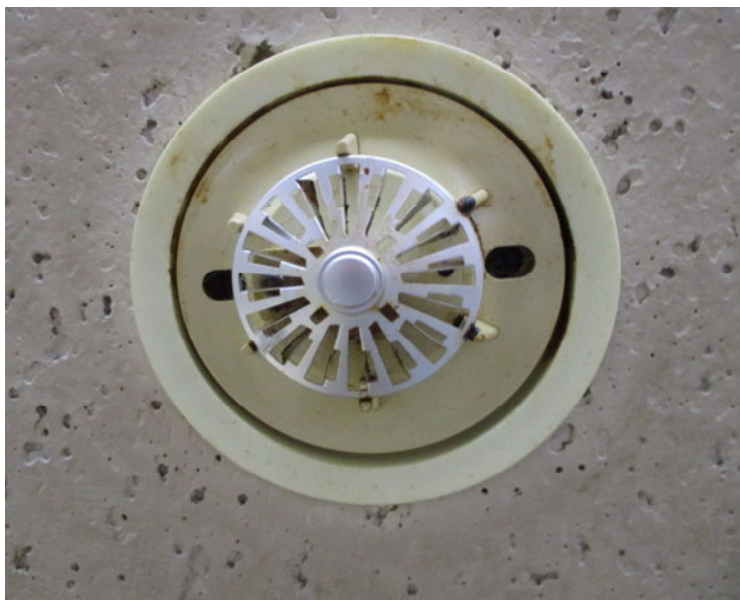
既設定温式スポット型感知器
