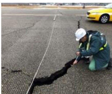
空港基本施設(滑走路等)の調査
