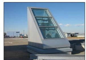
屋上に設置されている光ダクト採光部(他に2箇所の採光部あり)
