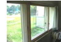
学校等の防音工事(防音サッシ・空調機)
