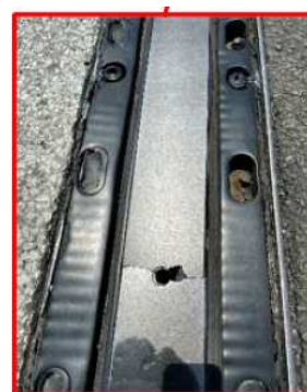
損傷状況 (部材の破断)
