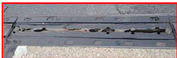
損傷状況 (表層ゴムの脱落と部材の破損)
