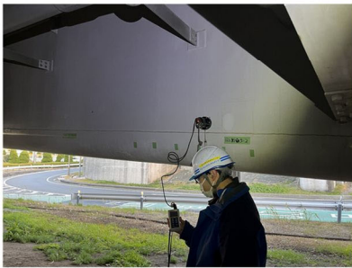
付戻り調査状況(2023/2/28)
