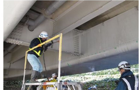
試験施工状況
