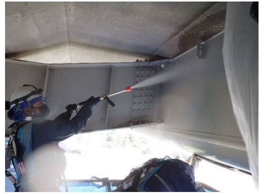
洗浄状況（近景）
