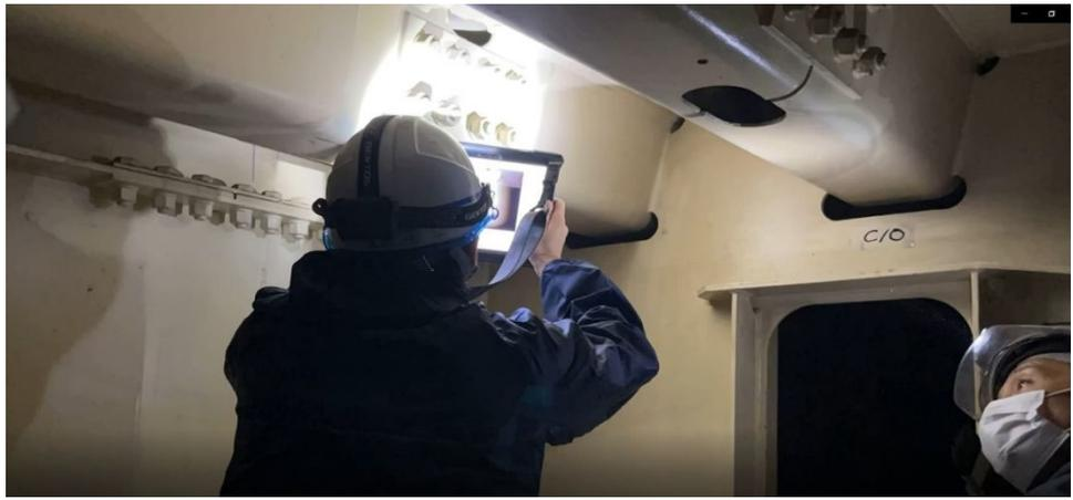
図-4.4 3D デジタル点検野帳を使った点検状況
