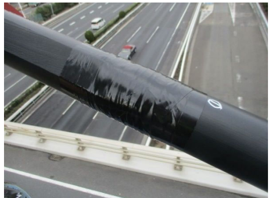
図-5.5 防水テープ補修状況
