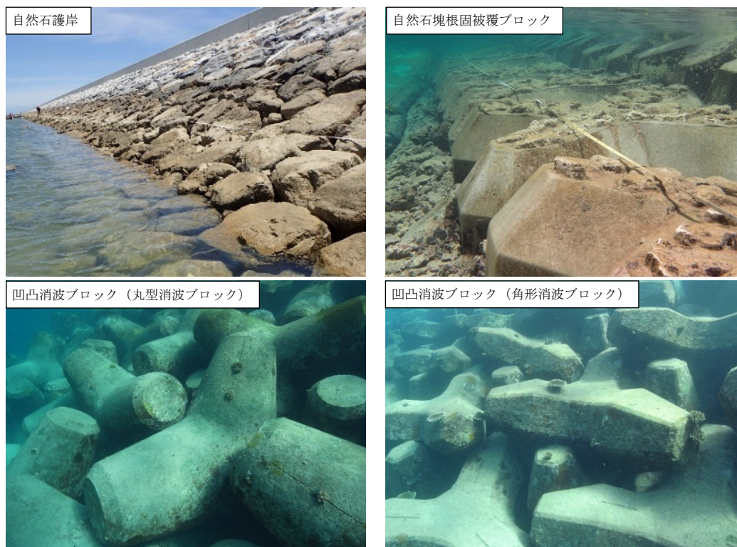
図－ 9.1.75 護岸における環境保全措置実施状況
