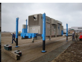
可搬形発電設備を設置
