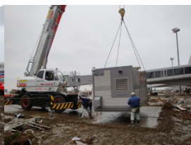
可搬形発電設備を設置
