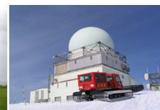
レーダー施設
