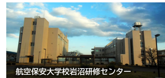
国土交通大学校柏研修センター
