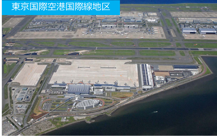
国際線旅客ターミナルビル
