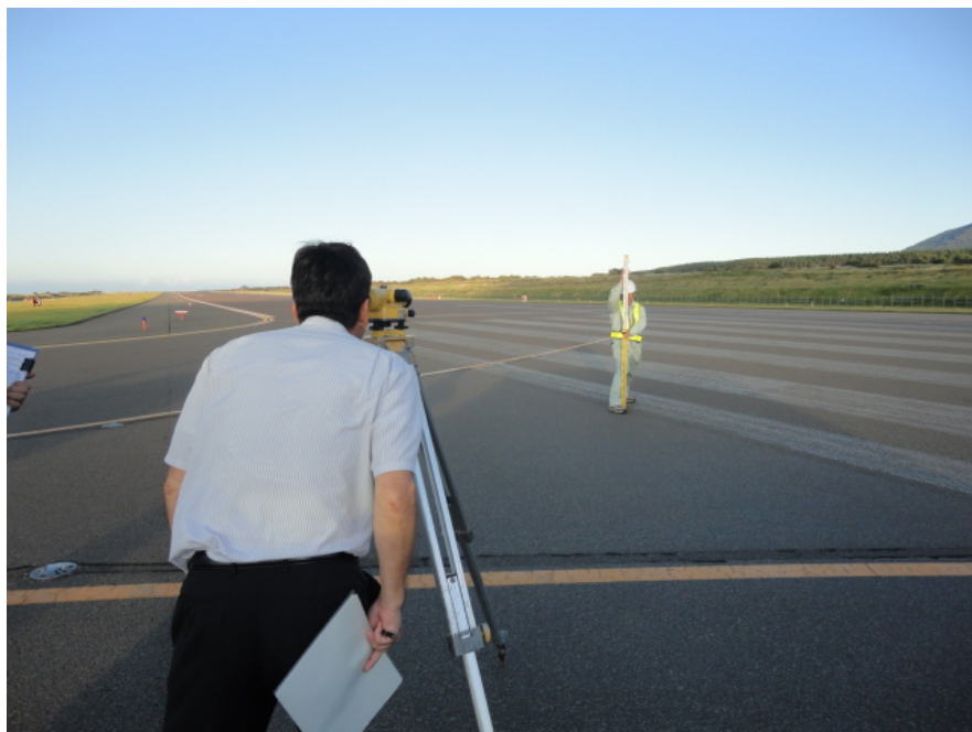
航空法に基づく滑走路の勾配を満たしているか監査している様子 （利尻空港（北海道））
