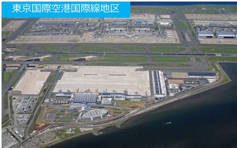
国際線旅客ターミナルビル
