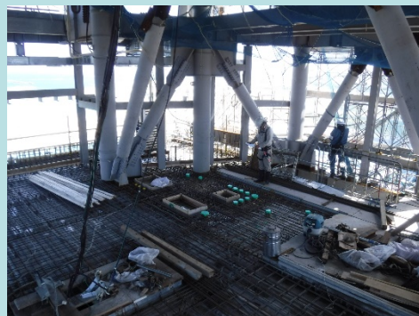
管制塔 (施工状況)
