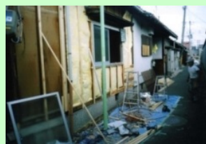
住宅の防音工事
