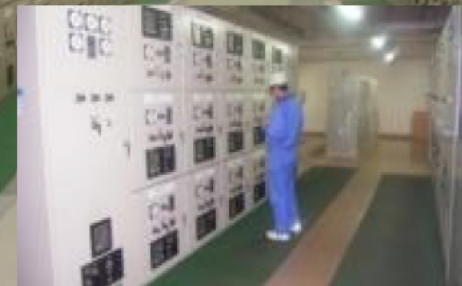
電気施設の日常点検
