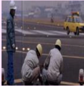
灯火の交換作業
