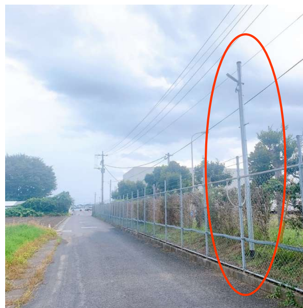
※鹿児島空港給油施設株式会社の敷地内に外灯7基を設置
