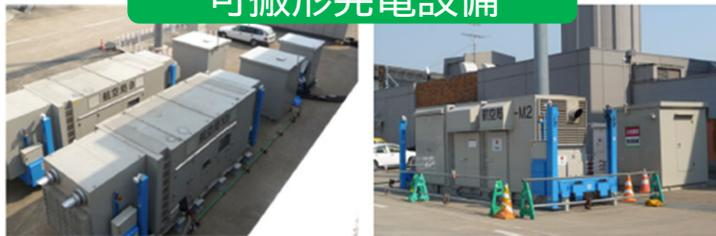
自然災害をはじめ航空保安施設等における電源障害時の電源確保のため展開される、運搬が容易な発電設備。
