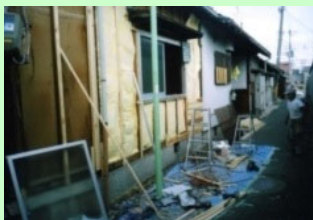
住宅の防音工事
