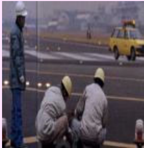
灯火の交換作業
