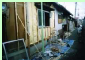
住宅の防音工事
