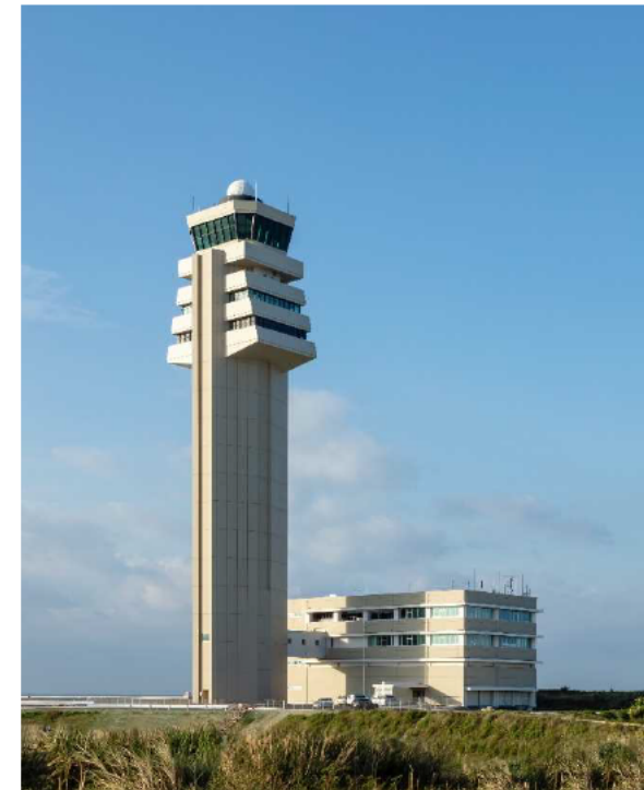
R C造 地上約90m (竣工R1.10)
