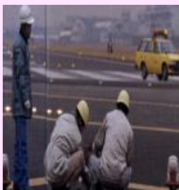
灯火の交換作業
