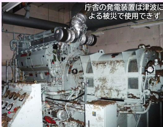
庁舎の発電装置は津波による被災で使用できず
