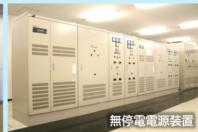
非常用発電装置
