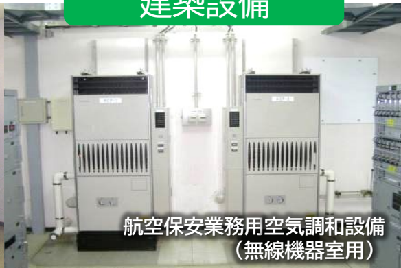
航空保安業務用空気調和設備 (サーバ機器室用)
