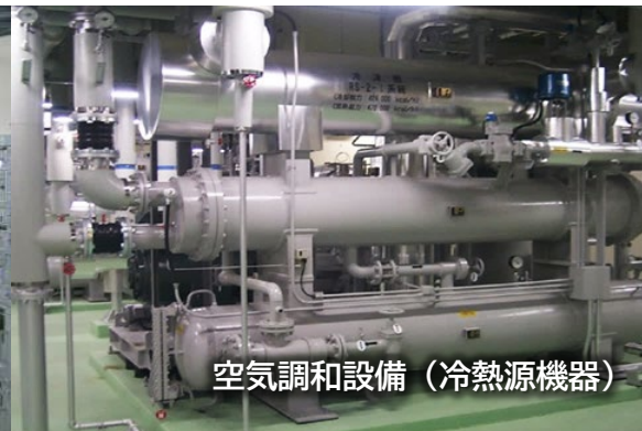
航空保安業務用空気調和設備 (無線機器室用)
