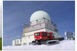
レーダー施設
