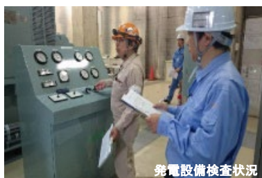
発電設備検査状況
