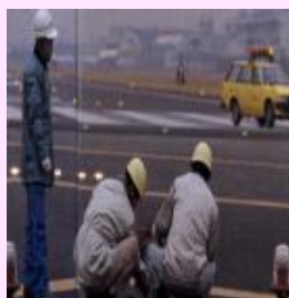
灯火の交換作業
