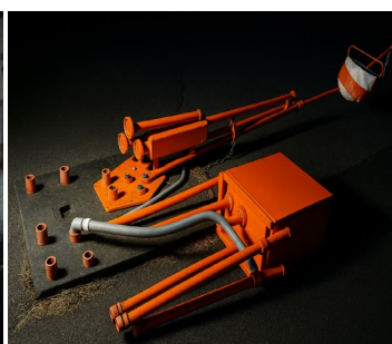
航空灯火電気施設の調査
