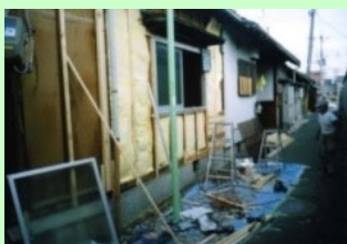
住宅の防音工事
