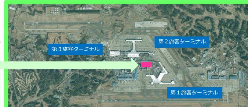
現状 (空港全体)
