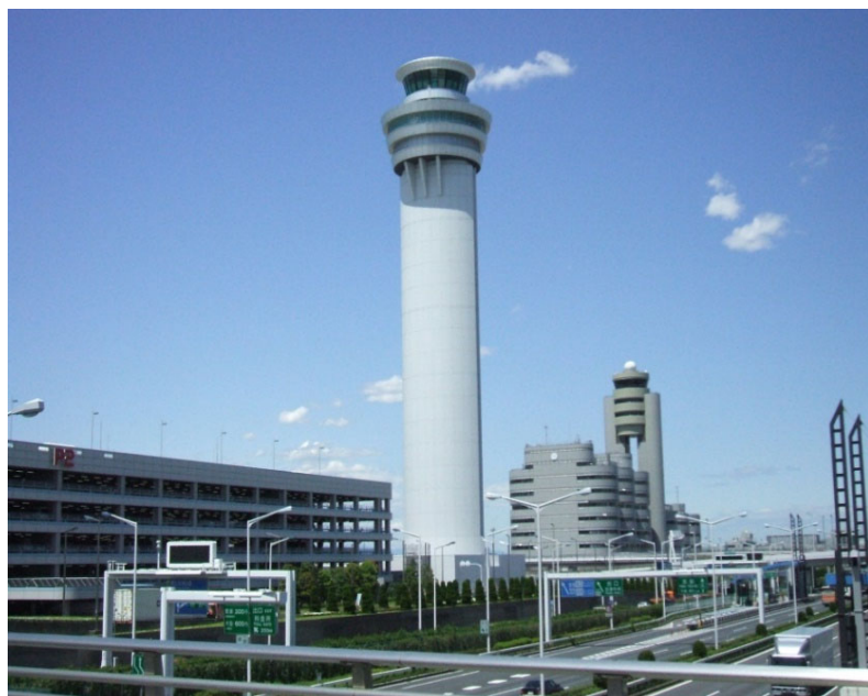
管制塔整備事例
