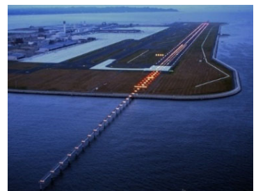
進入灯橋梁・航空灯火
