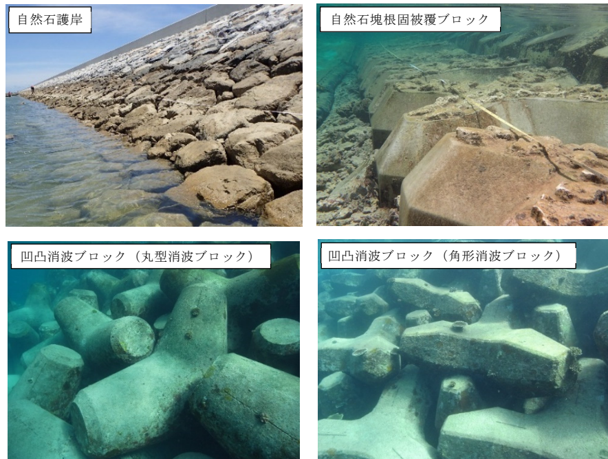
図－ 9.1.46 護岸における環境保全措置実施状況
