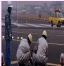
灯火の交換作業
