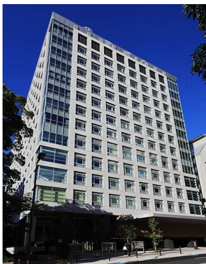
大手前合同庁舎(外観)
