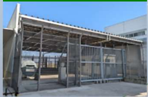
制限区域への出入りを管理する電動ゲート
