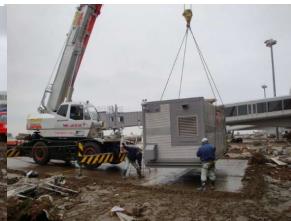
可搬形発電設備を設置
