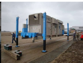
可搬形発電設備を設置
