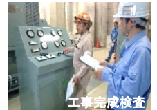
工事完成検査
