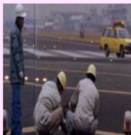
灯火の交換作業
