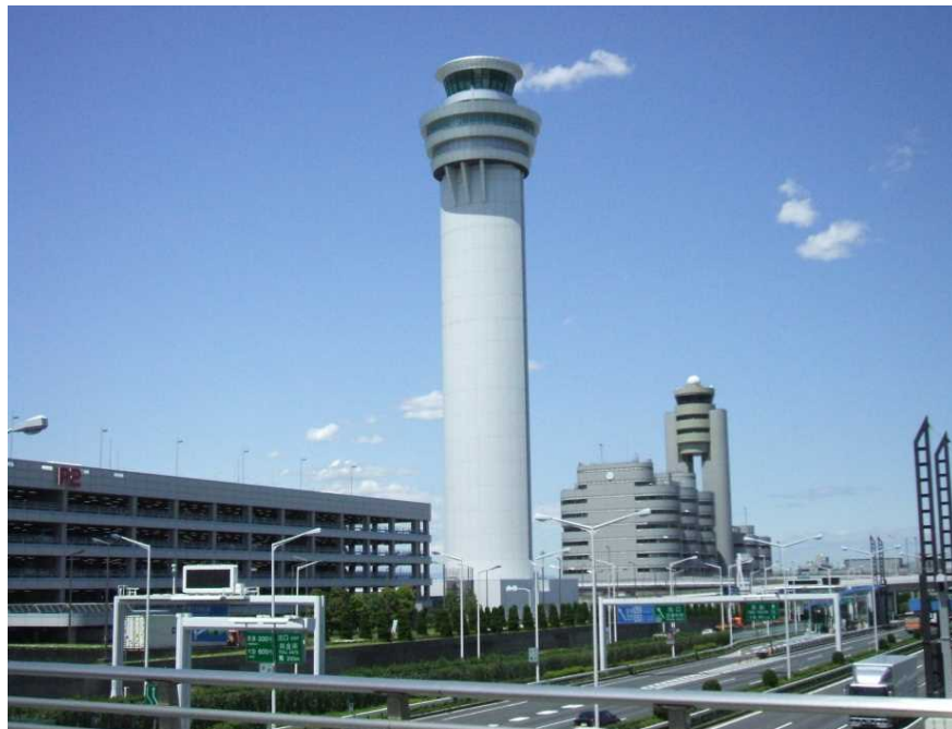
RC造、地上約116m（世界5位） 中間階免震及び制振装置（風対策）を採用
