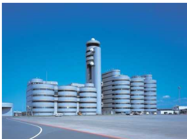
東京国際空港庁舎・管制塔
