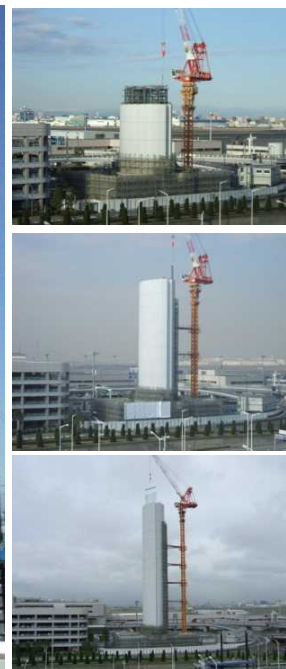
RC造、地上約116m（世界5位） 中間階免震及び制振装置（風対策）を採用
