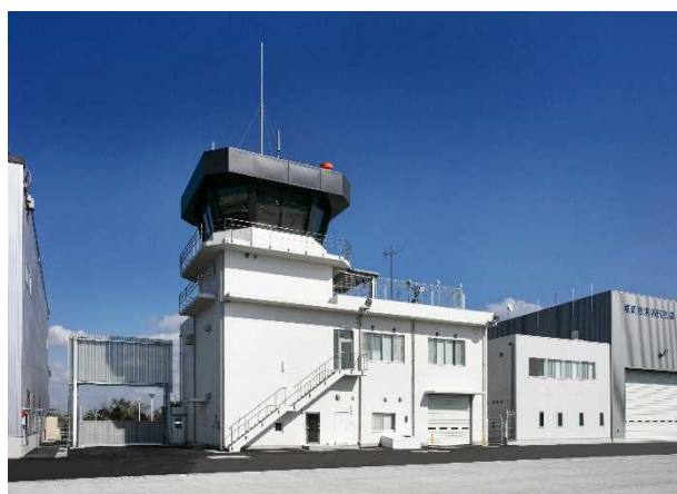
福岡空港(奈多地区)管理庁舎
