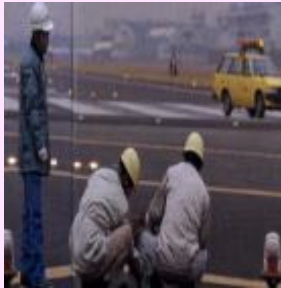
灯火の交換作業
