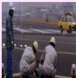
灯火の交換作業
