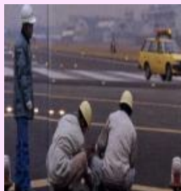
灯火の交換作業
