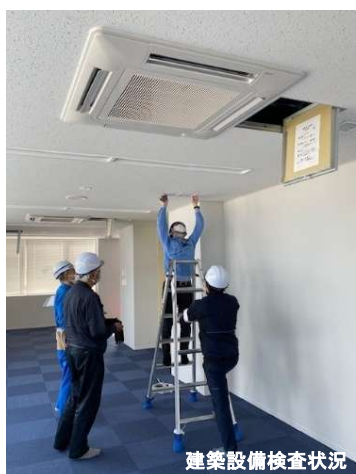
建築設備検査状況
