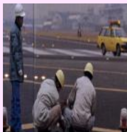
灯火の交換作業
