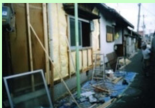
住宅の防音工事
