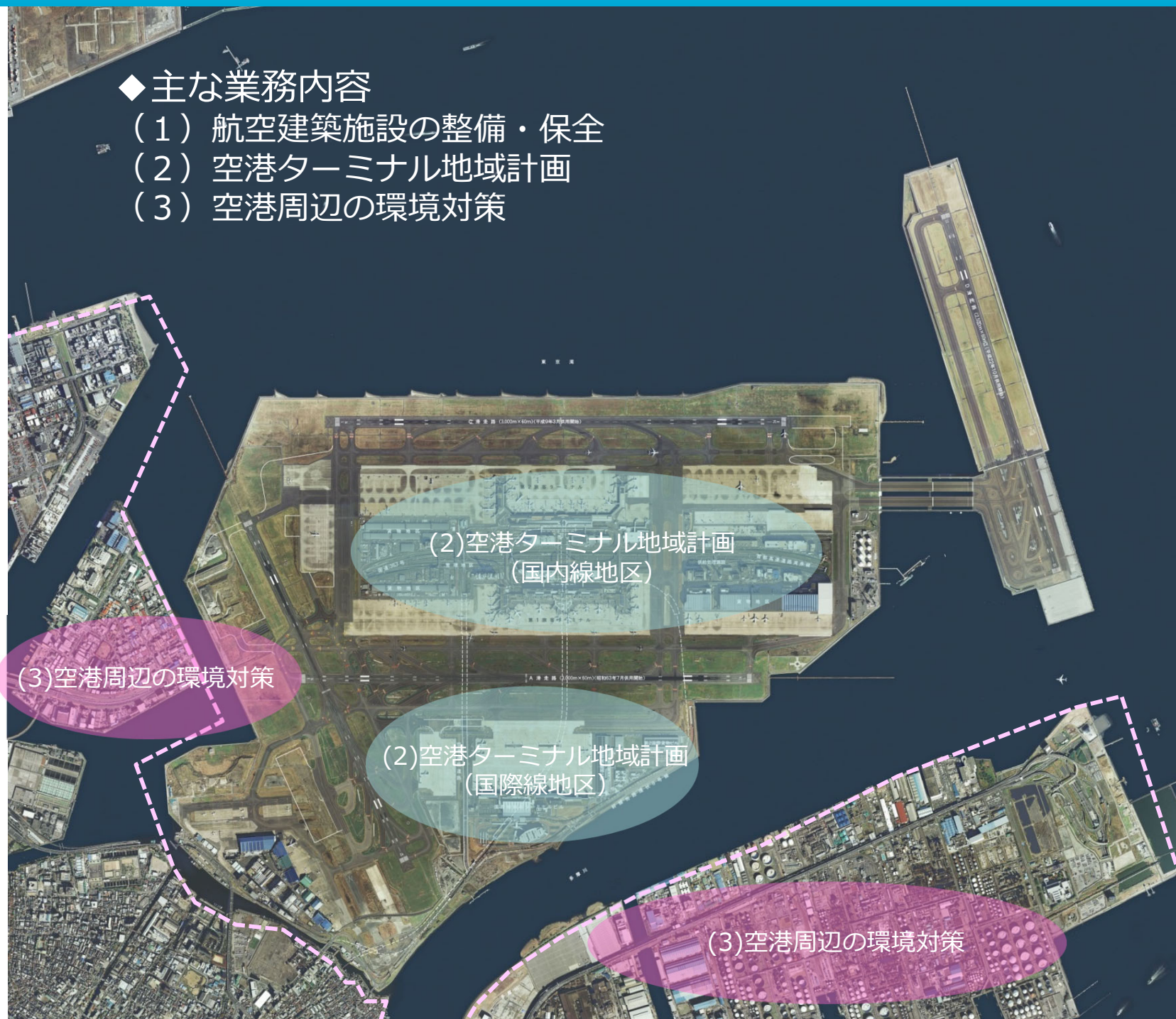
(1) 航空建築施設の整備・保全
