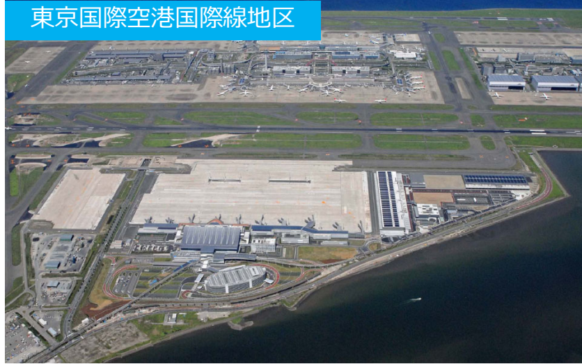
国際線旅客ターミナルビル
