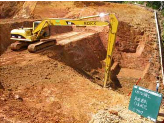
大型擁壁設置前の切土
