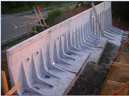
T型擁壁設置
