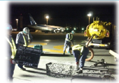
(空港制限区域内での土木工事)
