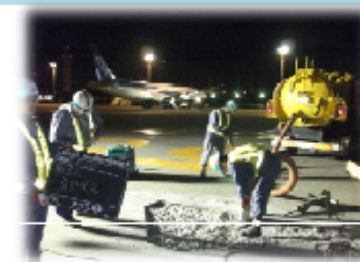
(空港制限区域内での土木工事)
