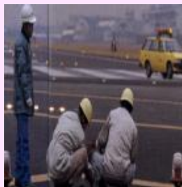
灯火の交換作業
